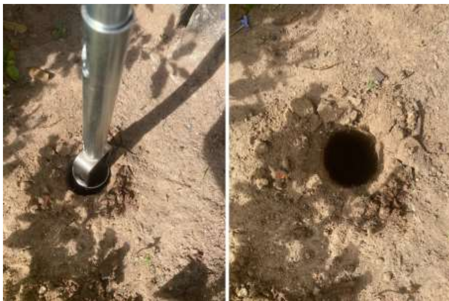
Figura 18 - Fase inicial de preparação do furo
