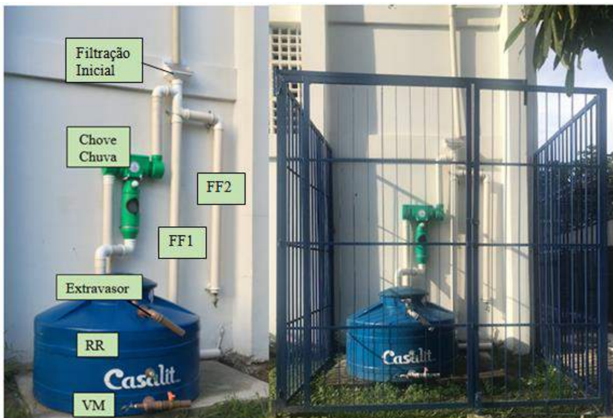
Figura 11: Sistema de captação, tratamento e armazenamento de água de chuva da UERJ.
