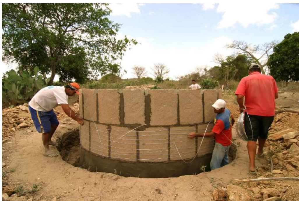
Figura 15: Cisterna em placa de cimento pré-moldado Fonte: ASA BRASIL, 2014
