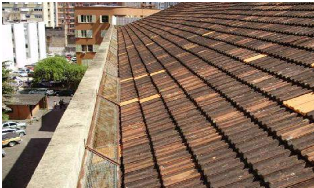
Figura 9: Instalação de tela para impedir acúmulo de folhas na calha Fonte: APERS, 2012
