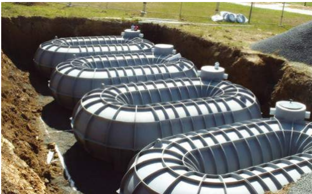
Figura 14: Cisternas em polietileno para armazenamento de água de chuva Fonte: FORTLEV, 2014
