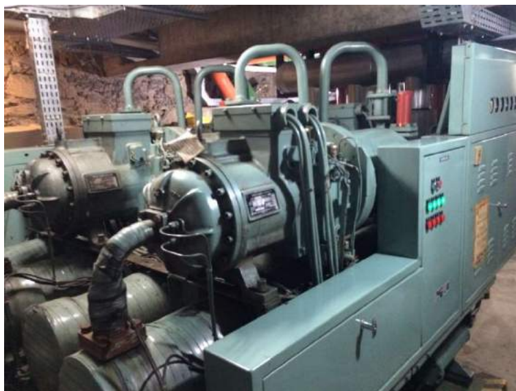
Figura 12 – Sistema de refrigeração - Chiller
