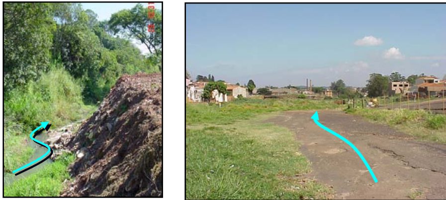
Figura 2 – A esquerda: seção do córrego em desvio por compressão de aterro de talude. A direita: sobreposição de asfalto em curso d' água
