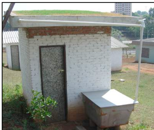
Figura 2 – Sistema de protótipo de CVL com armazenamento de águas pluviais.
